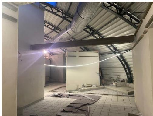
En ce moment, c'est l'entreprise de carrelage qui intervient pour poser la faïence du bassin : 25m de long x 10m de large, sur une profondeur de 2,20 m au grand bain. Également en action, l'entreprise qui pose le liner d'étanchéité extérieur sur la coupole. Va s'en suivre le travail de fluides et de raccordement aux différents réseaux.
